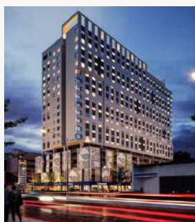
TORRE UNA 226 Departamentos 1358 Puertas Monterrey, NL
